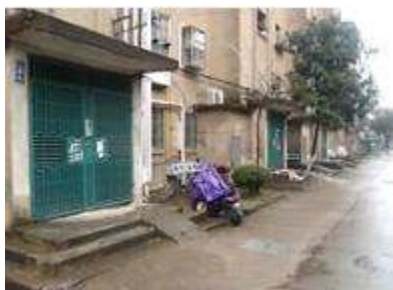
图 5-34 住宅楼出入口现有坡道
